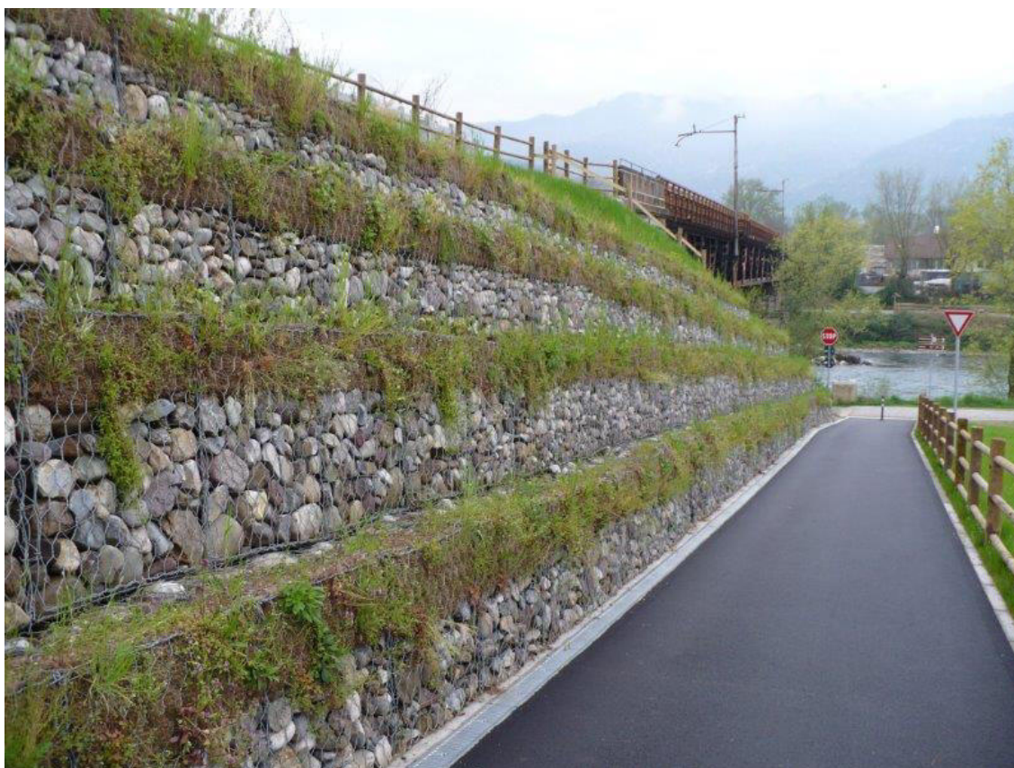
Fig. 3 Gabbionate con tasche verdi vegetative
