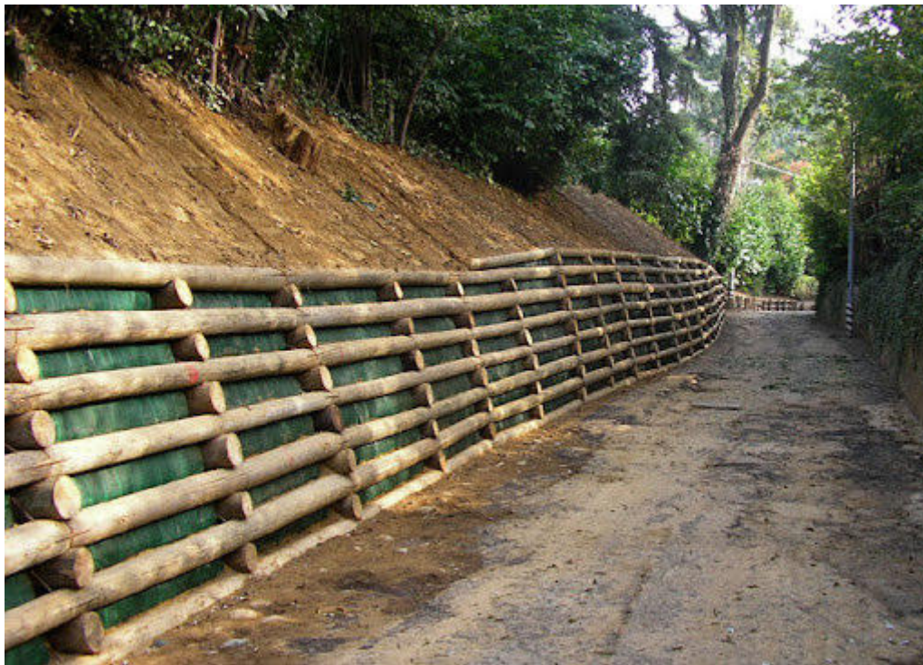
Fig. 4 palizzate in legno a doppia parete rinverdite con talee
